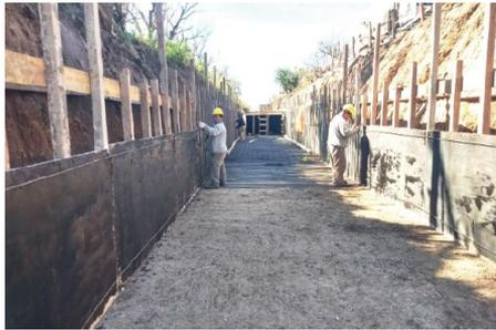
Los trabajos consisten en la construcción y soterramiento de un conducto de hormigón armado de 2.550 metros de longitud que se inició en la desembocadura del río y llegará hasta calle Batalla de San Lorenzo. Además, está prevista la aplicación de mejorado pétreo a lo largo de la traza intervenida.
